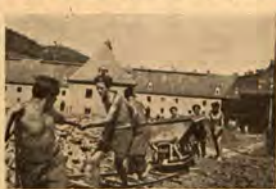
На обекта кипи съревнование
