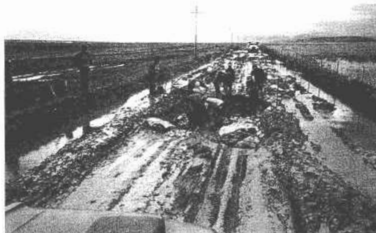
Estado corriente de la ruta que une Puno y Cuzco durante la época de lluvias hasta 1994.
