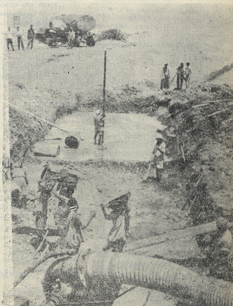
Un aspecto de los trabajos.
