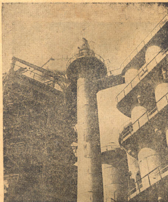
მარცხენა—ლიბეცის მეტალურგიული ქარხნის „თავისუფალი შვედენის“ ბრძმედი № 1 და კაუბერები. მარჯვენა—ქერჩის მეტალურგიული ქარხანა. ანა-ლი მძლავრი ჰაერის საბერველის მეორე კოლონის დაღება
