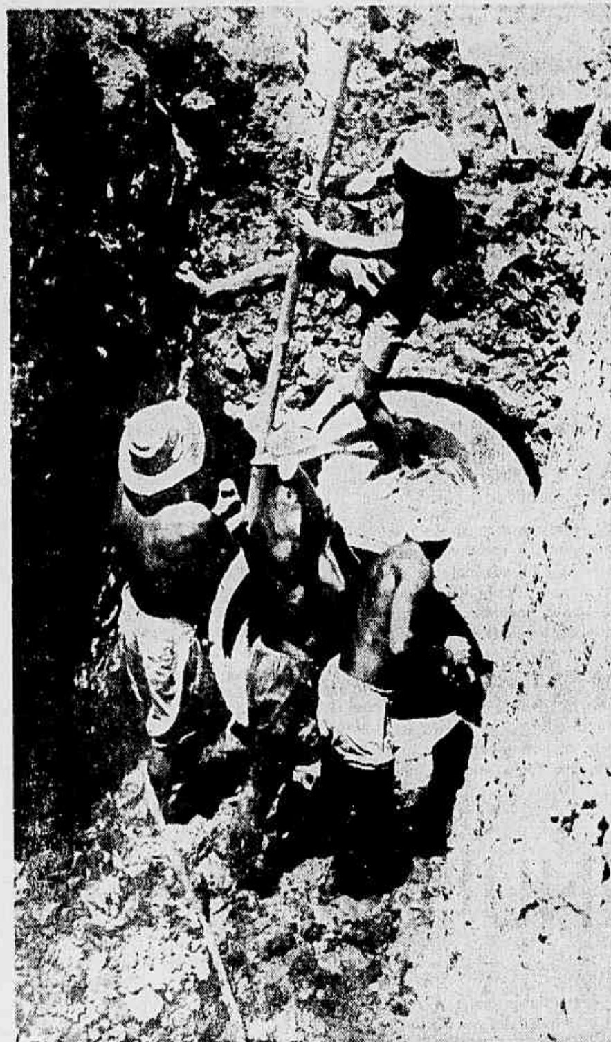
Saneamento e pavimentação
