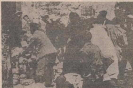
CONSTRUÇÃO DUMA BARRICADA EM BARCELONA
