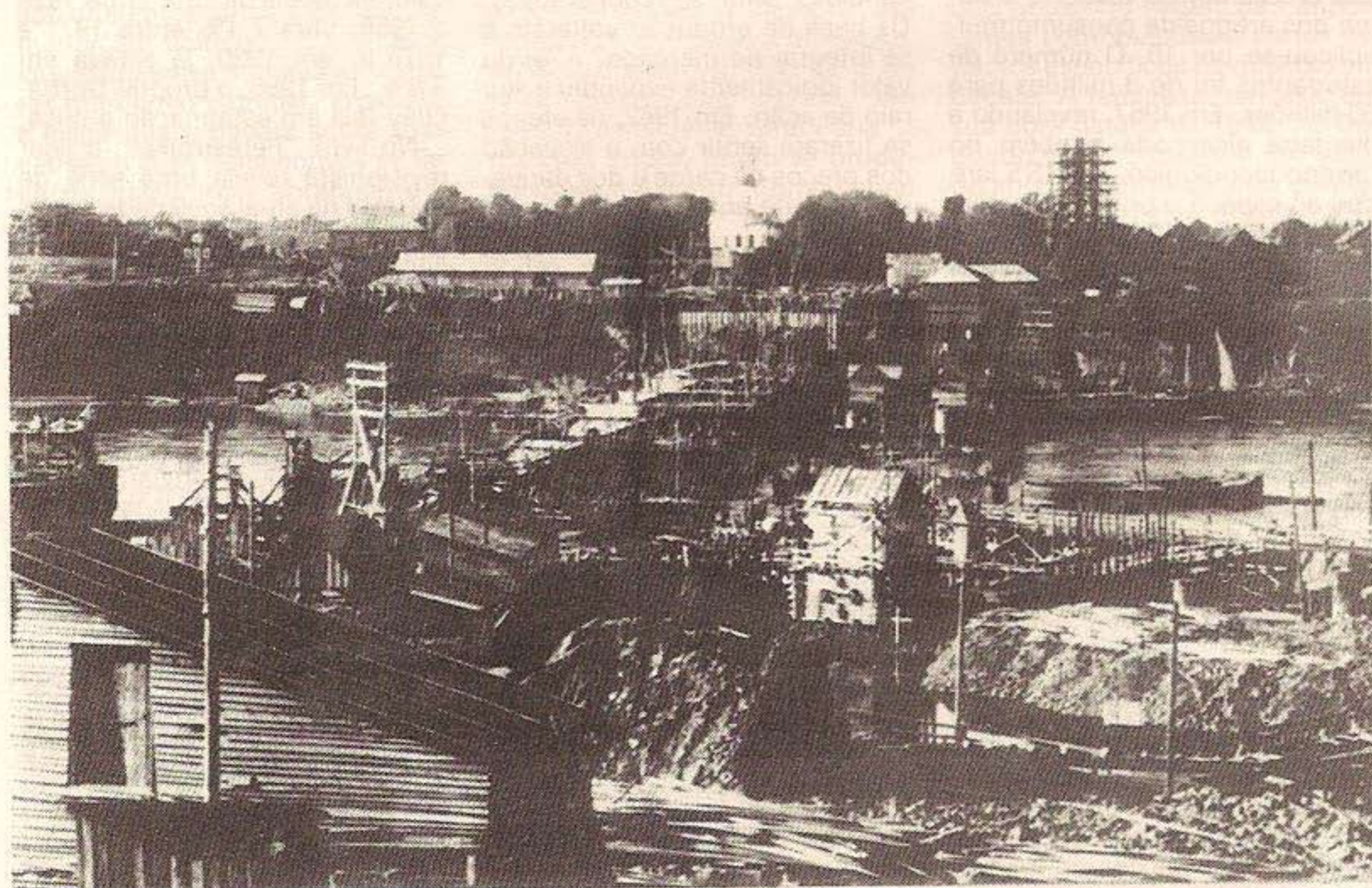
Construção da hidrelétrica de Vóljov — 1923.
