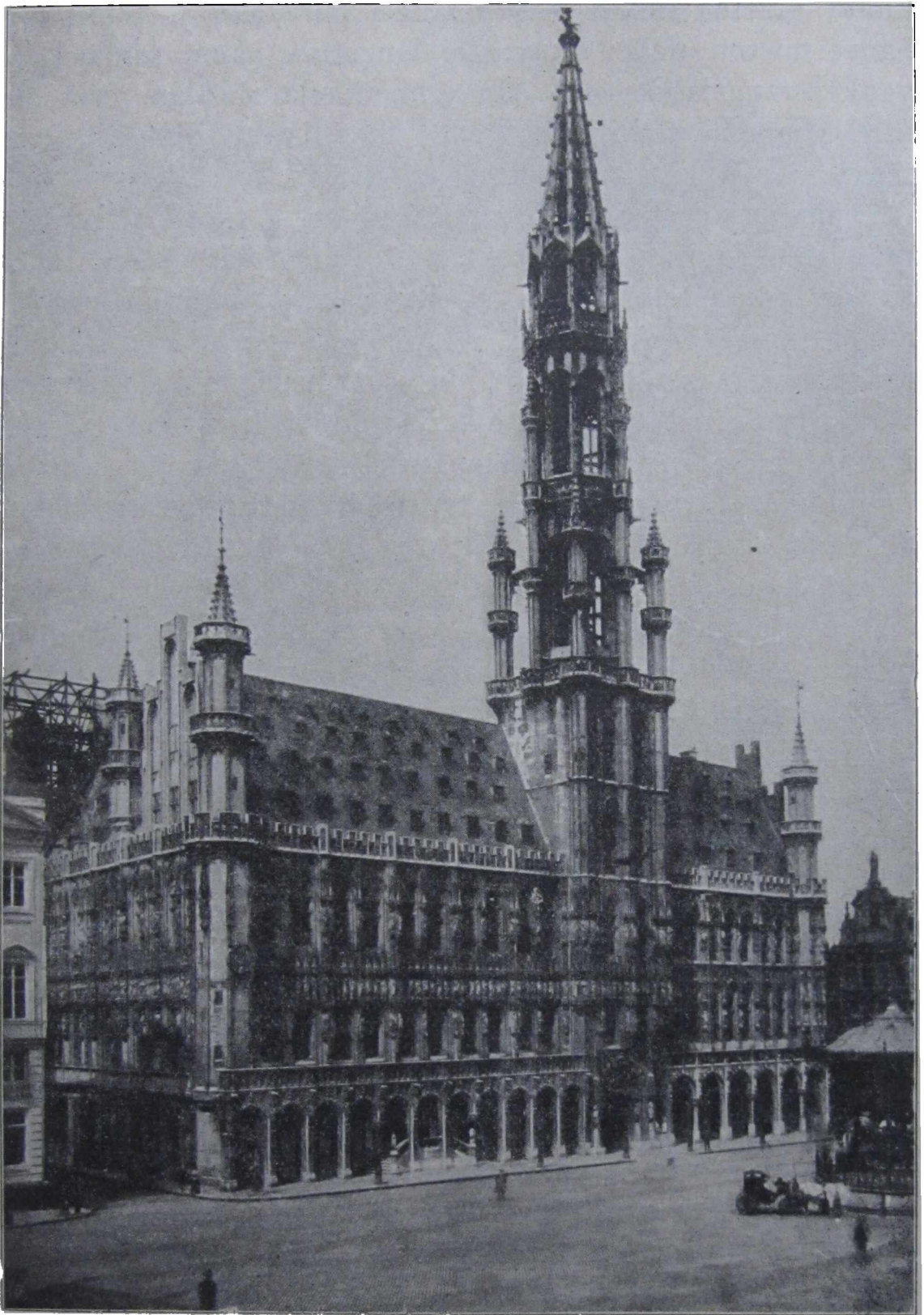
Brysselin raatihuone. Rakennettu 15. vuosisadan alkupuoliskolla.
