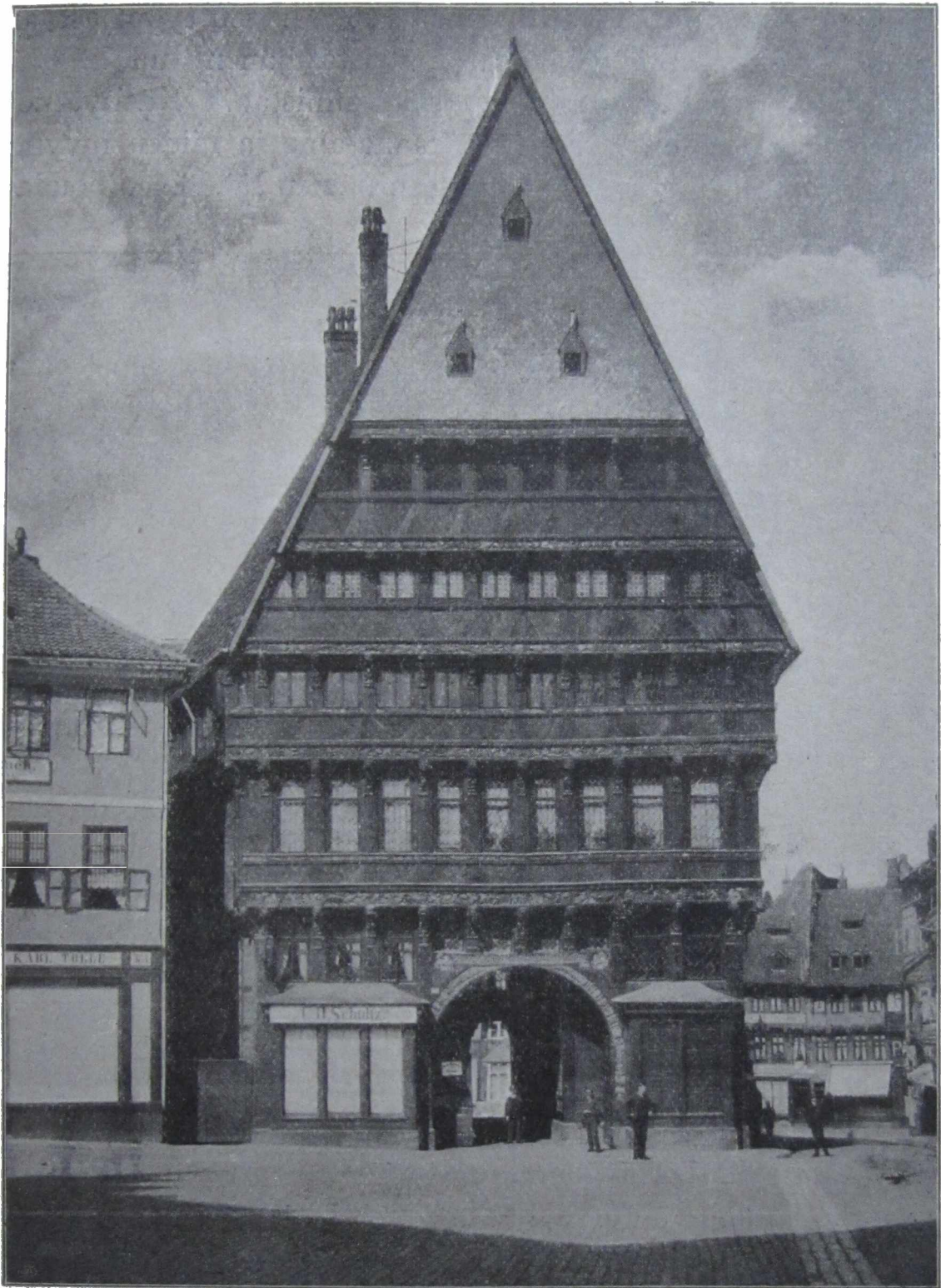
Teurastaja-ammattikunnan talo Hildesheimissä. Rakennettu 15. vuosisadan alkupuolella.
